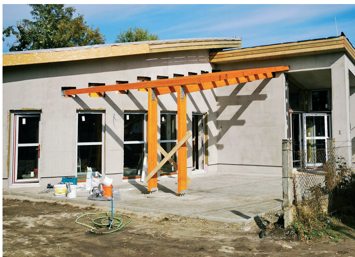
Jó ütemben halad a bölcsőde építése
